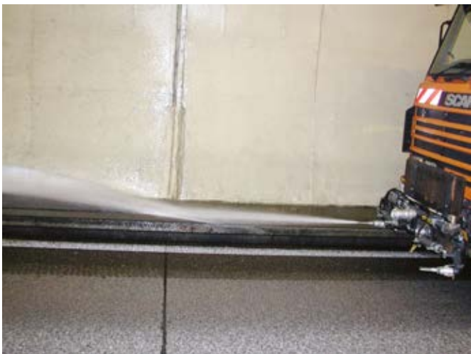
Tunnelreinigung
